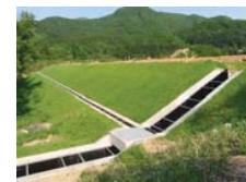
3. 山間部や吹付法面の小段側溝等に、モルタル吹付による簡易的な側溝を採用
