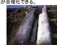
4. コンクリート二次製品に専用治具取付け用の加工を施す
